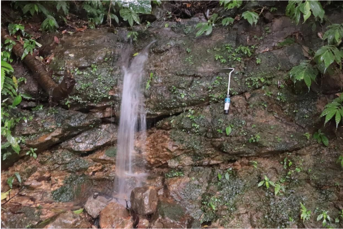
圖 25 灰白色塊狀砂岩露頭照片。露頭可見多組裂隙，整體呈現破碎樣貌，攝於粗坑路照片點 4。
