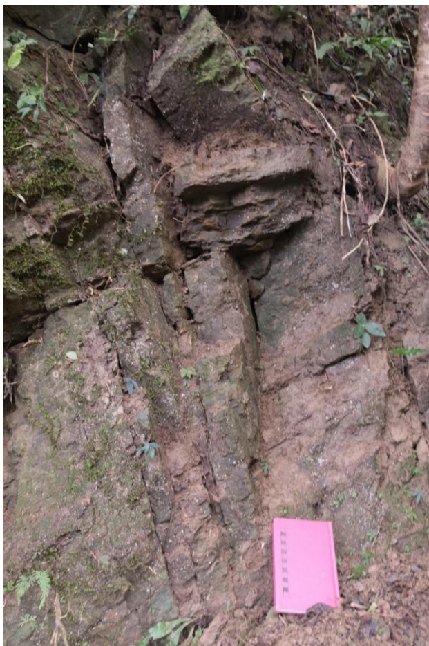
圖 27 照片點 6 之塊狀灰白色砂岩露頭照片。露頭發育多組高角度裂隙，整體呈現破碎樣貌。
